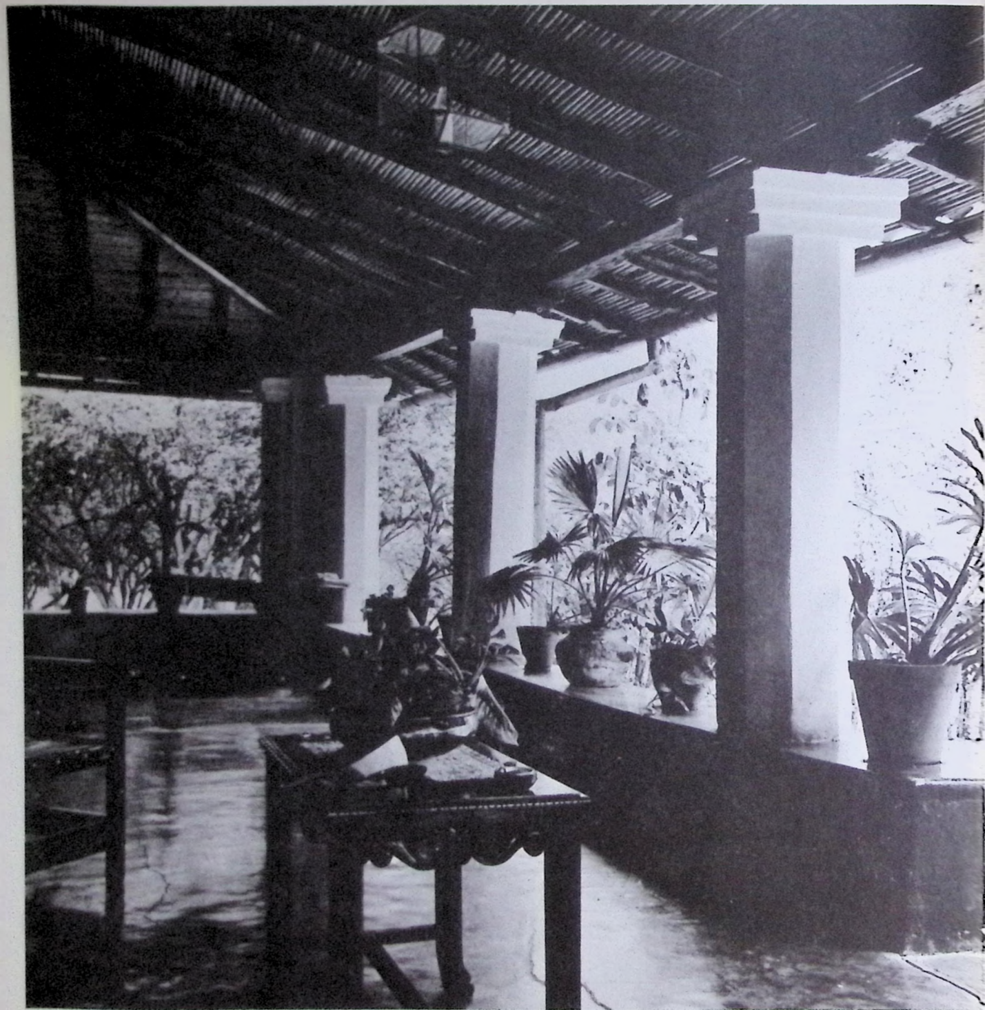
116 - Pilares octogonales sobre un podio liso corrido en la hacienda "El Tazón" (San Francisco de Yare, Edo. Miranda).
