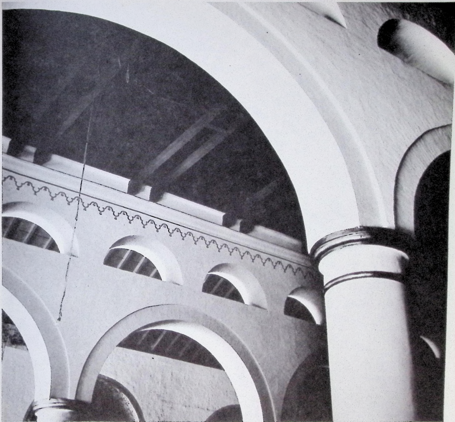
206 - Ejemplo de iglesia con las tres naves separadas por serie de columnas cilíndricas y arcos de medio punto. Catedral de Barcelona (Edo. Anzoátegui).
