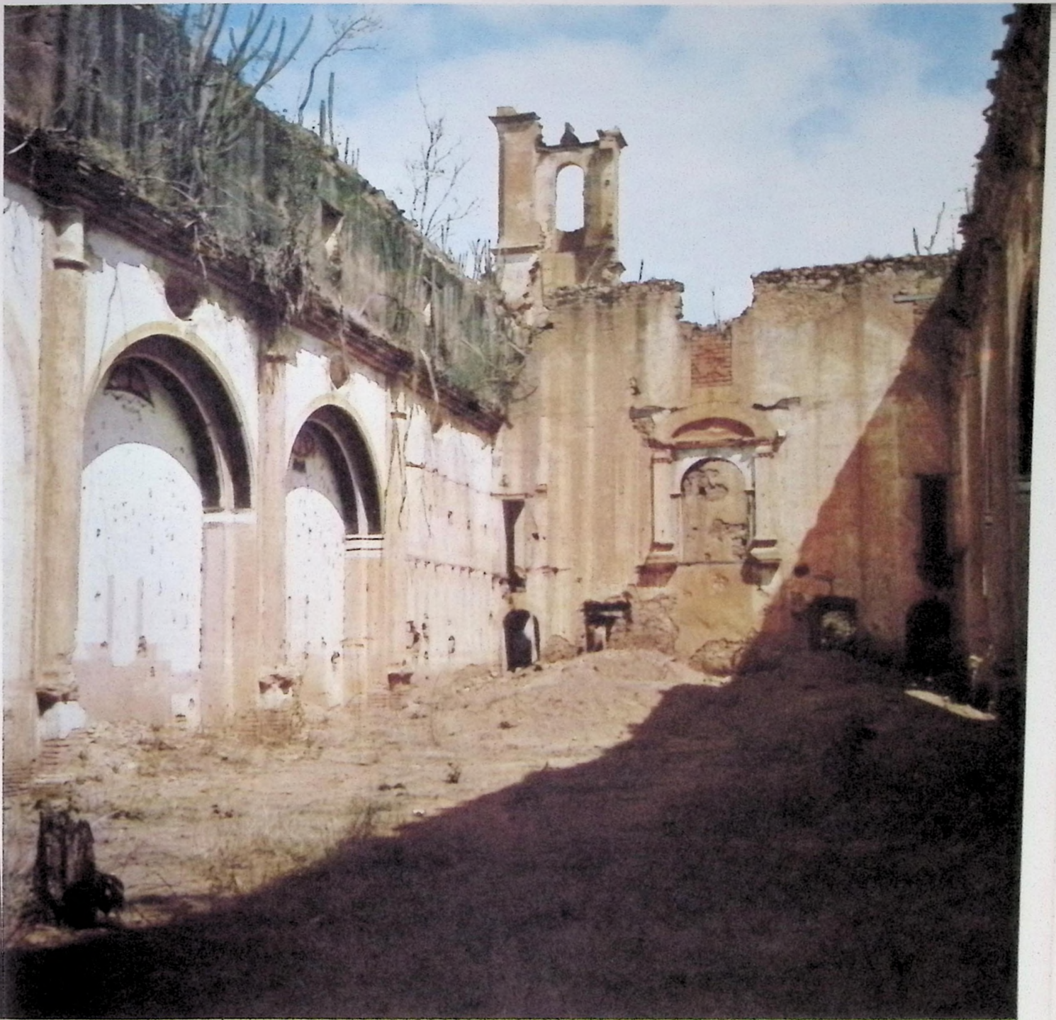
201 - Ruinas del templo de la Purisima Concepcion del Caroni en la Guayana. Los muros perimetrales — como un gran recinto — determinan la extrema sencillez espacial del interior.
