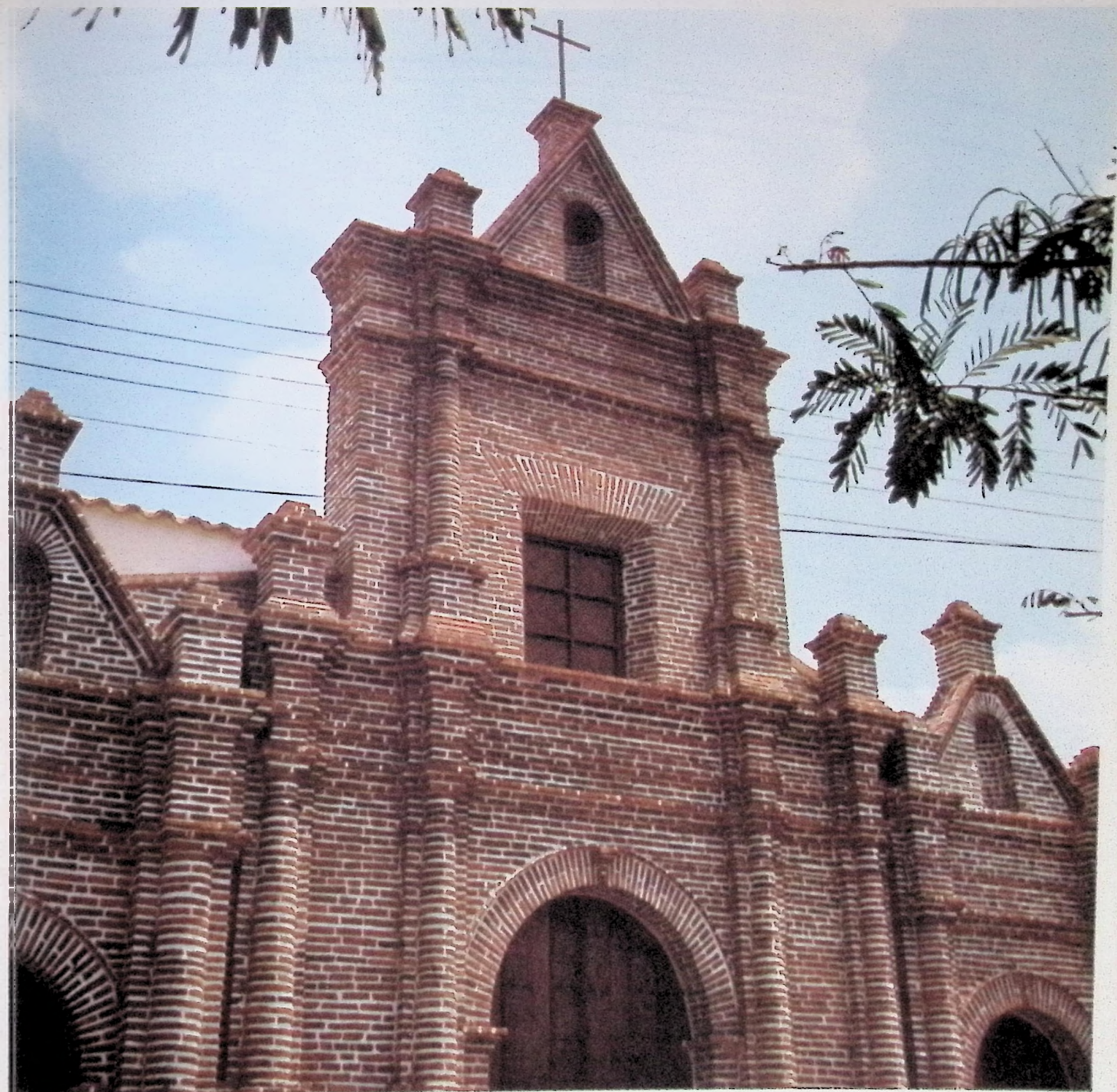
241 - La fachada de ladrillos del templo de Araure (Edo. Portuguesa).
