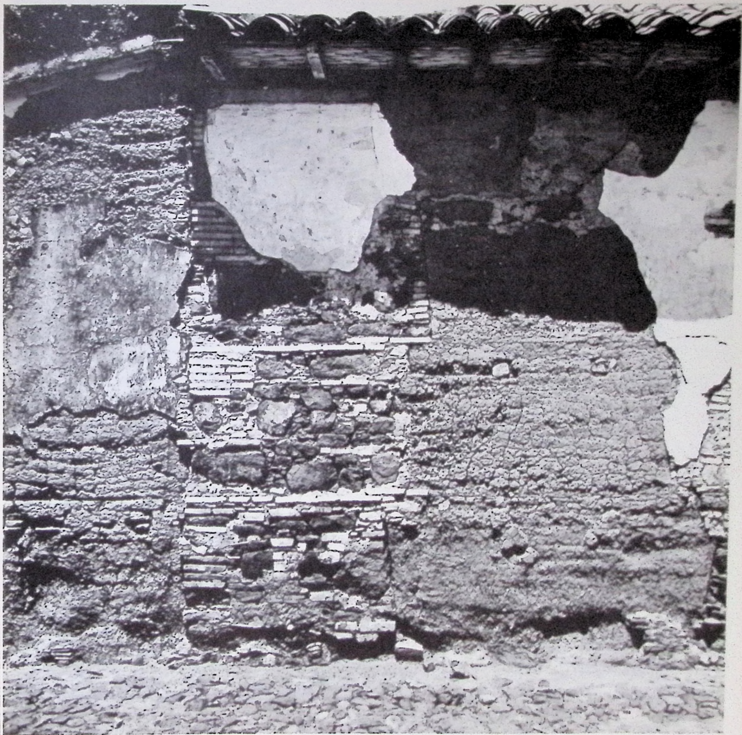
347 Las rafas adinteladas confieren solidez a los muros de tierra apisonada.
