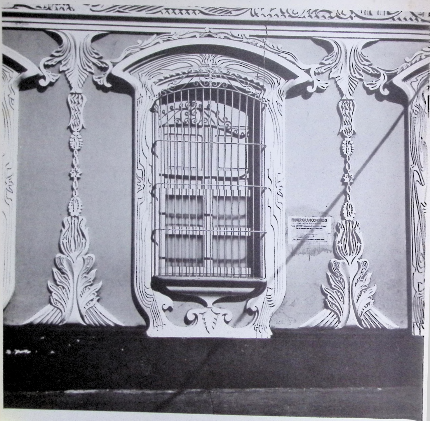
360 - Otro ejemplo de adaptación a los modismos decorativos de comienzo de este siglo. Los elementos ornamentales aparecen en las fachadas, atrás siguió vigente la distribución colonial. San Cristóbal (Edo. Táchira).
