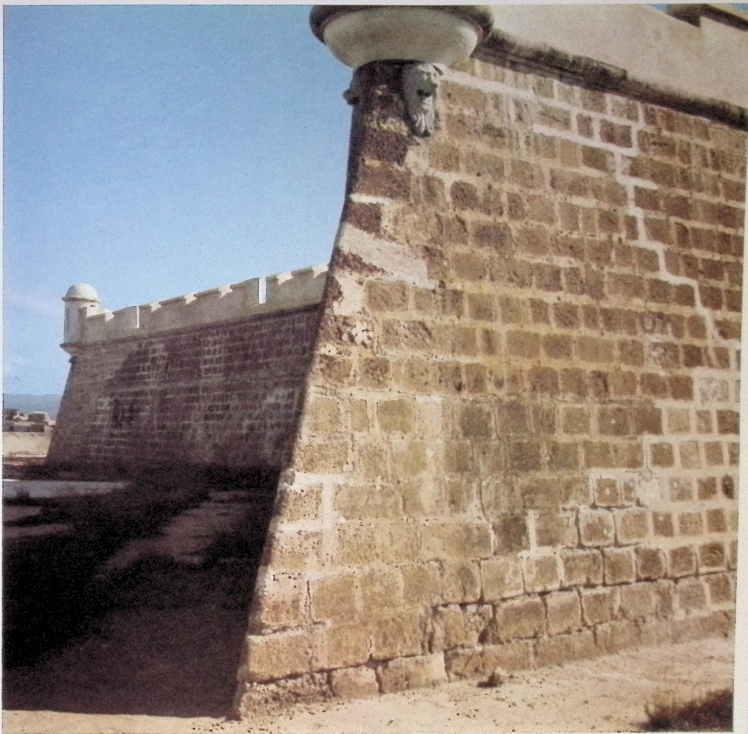
311 - Vista parcial del Castillo de San Antonio de la Eminencia, en Cumaná (Edo. Sucre).
