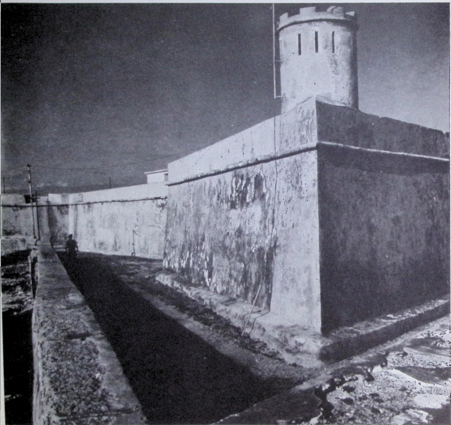
332 - Baluartes del castillo de San Carlos en la entrada de la barra del Lago de Maracaibo (Edo. Zulia).
