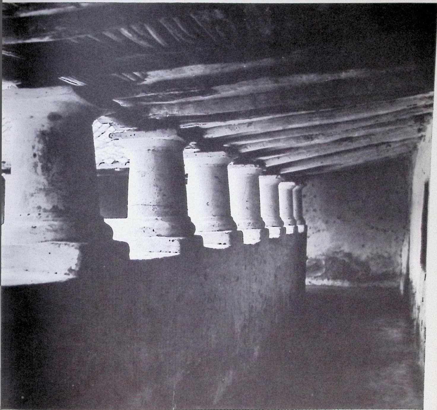
144 - Corredor con columnas toscanas sobre podio en Los Taques (Edo. Falcón).
