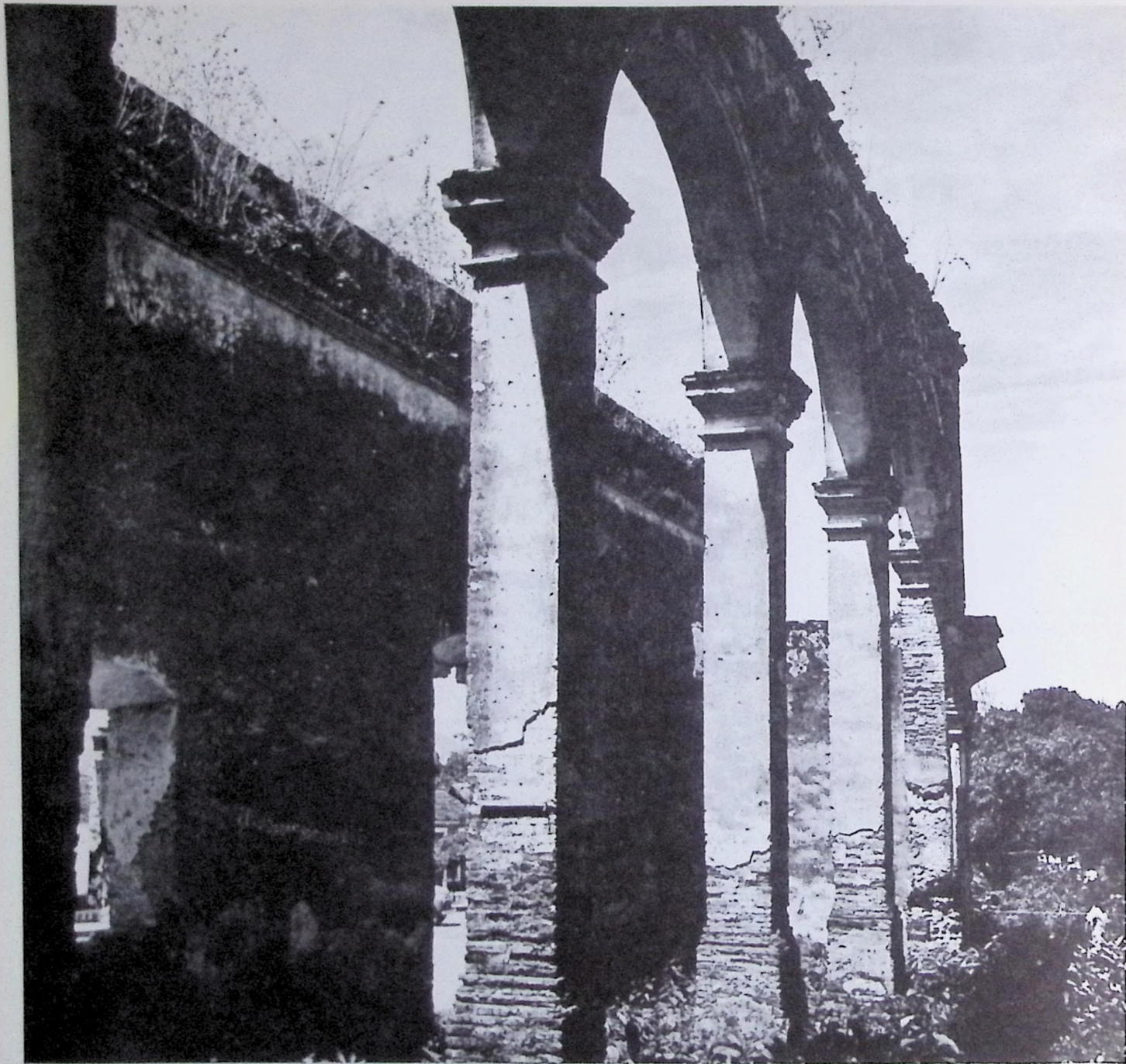
210 - Otro ejemplo de arquerías sobre pilares en las ruinas de Aricagua (Edo. Sucre).
