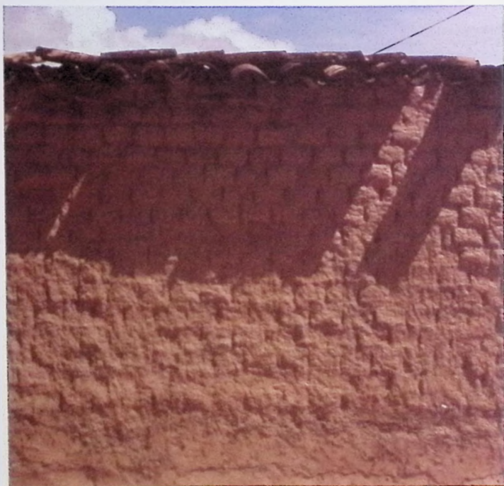
Otra pequeña casa de adobe en una calle de Quibor. (Edo. Lara). Abajo: muro de cerca en una casa de Bobare. (Edo. Lara). Página al lado: la textura del adobe en una casa de Caragua. (Edo. Aragua).
