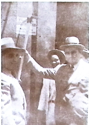
En los mismos actos de demolición, aparece Medina dando un piquetazo inicial a los trabajos. Lo rodean el Director-Gerente del Banco Obrero, Diego Nucete Sardi, a quien nombró en su último Gabinete Gobernador del Distrito Federal.
