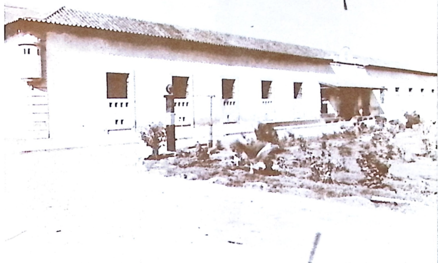
Fachada del Cuartel San Carlos .
